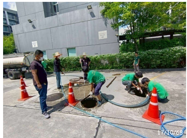
รูปที่ 2-10 เจ้าหน้าที่สูบล้างและกากตะกอนจาก ระบบบำบัดน้ำเสีย
