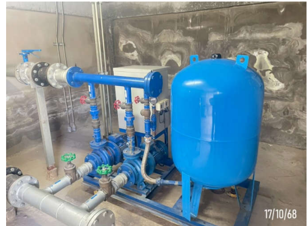
รูปที่ 2-14 Booster Pump
