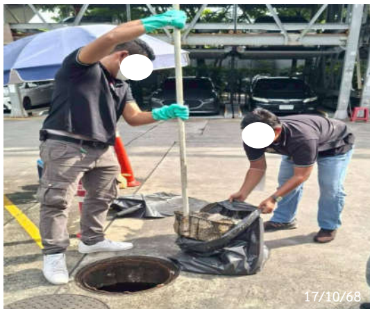
รูปที่ 2-9 เจ้าหน้าที่ตักไขมันจากถังดักไขมัน
